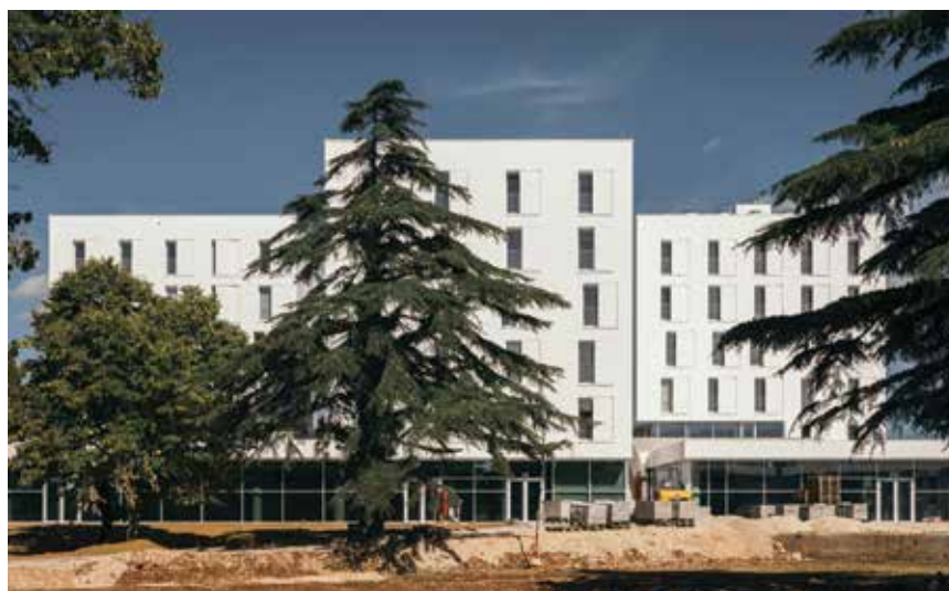
Zgrada studentskog doma i menze izvedena je kao niskoenergetska građevina
