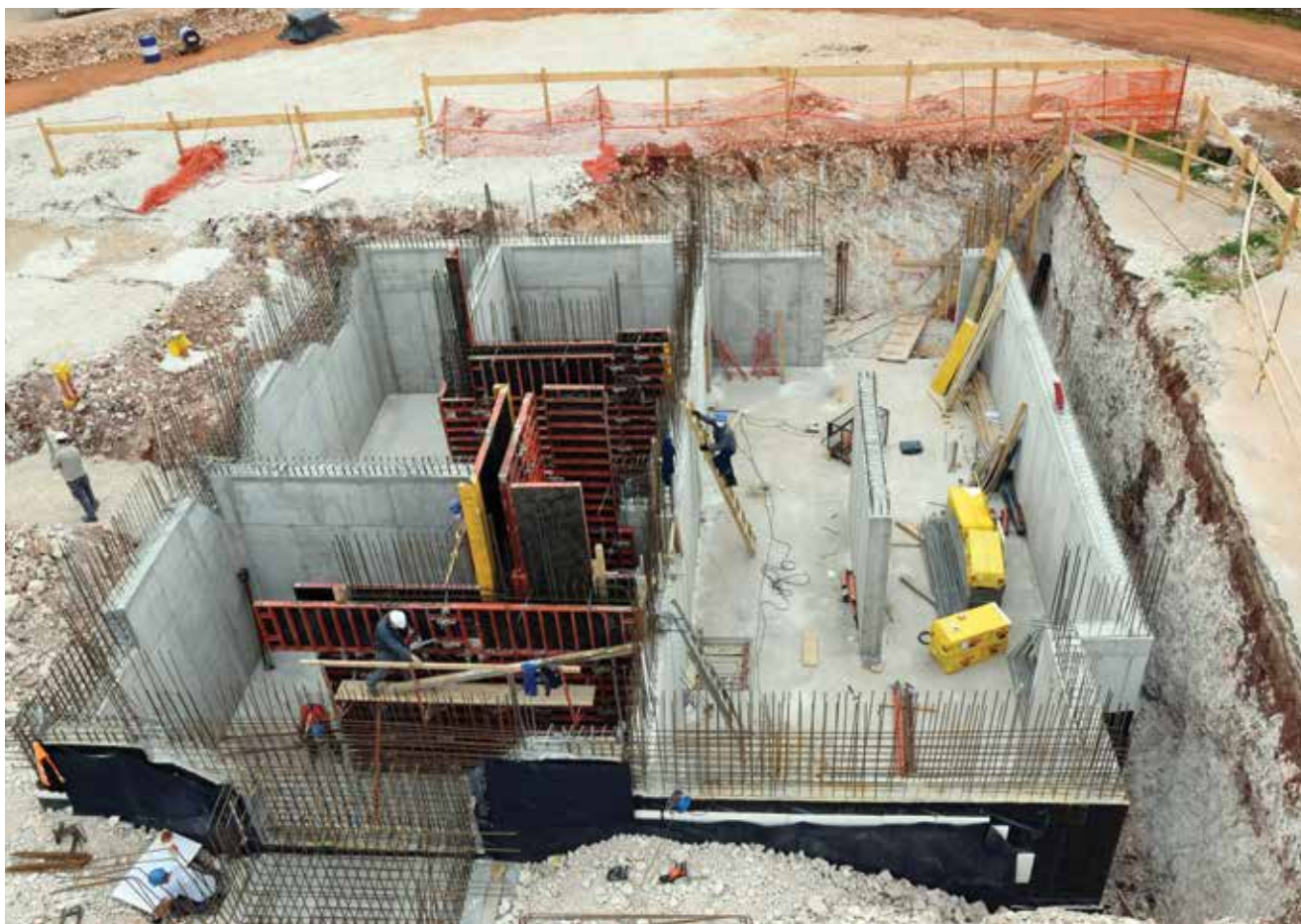
Armiranobetonski radovi na gradilištu
