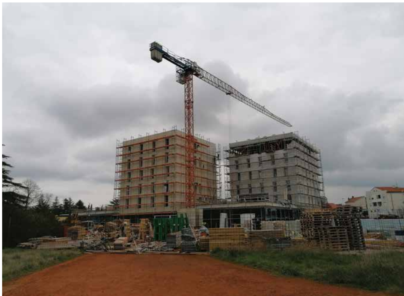
Detalj s gradilišta
